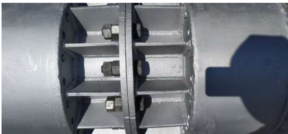
4-сурет-Тіректің төменгі және жоғарғы бөлігін құрастыру процесі
